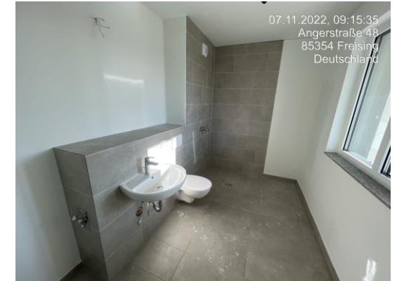
Badezimmer mit ebenerdiger Dusche
