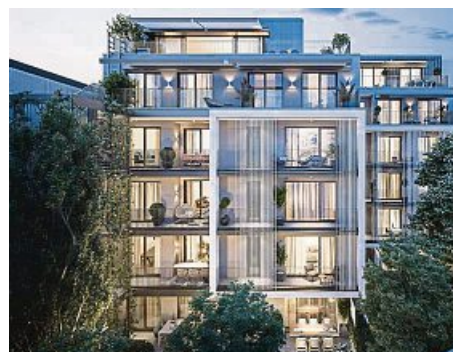
In den Max Höfen an der Türkenstraße entstehen 59 neue Wohnungen.
