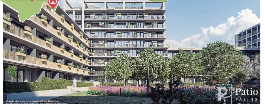
Unterföhrliche Darstellung aus Sicht im Einheitsmaß. Wohnungsplanung: Legat Living, Bayerische Hausbau, INDUWO Wohnbau, BPD Immobilienentwicklung, DEMOS Wohnbau
